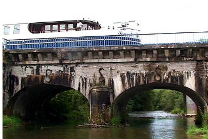
In Frankreich gibt es merkwürdige Brückenkonstruktionen
